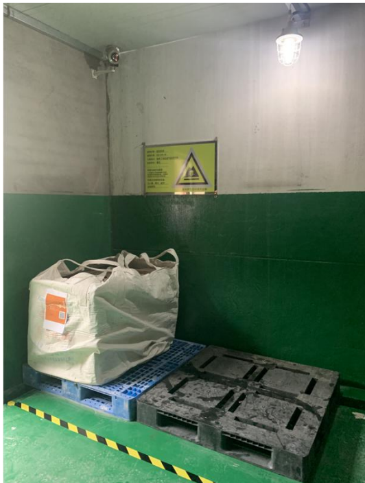
危废仓库内部：
